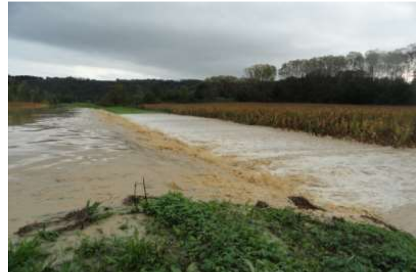
Déversoir en fonctionnement Crue du 30/10/2013
