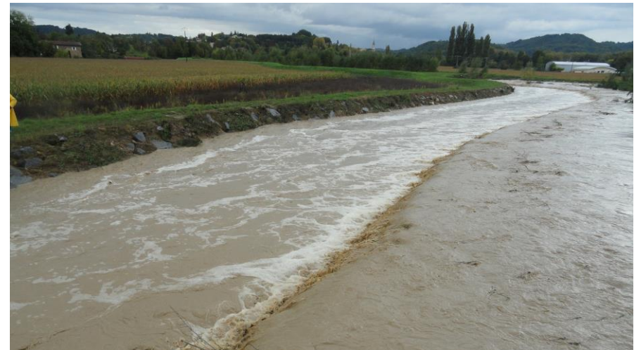
Surverse alimentant le canal de lors de la crue d'octobre 2013
