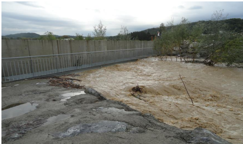
Poutre de contrôle des débits de la Savasse en charge lors de la crue d'octobre 2013
